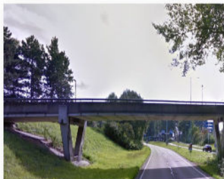
Prefab betonnen liggers - fiets- en voetgangersoverkluizing 📍 Zoetermeer
