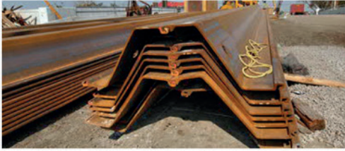
hergebruikte stalen damwanden
