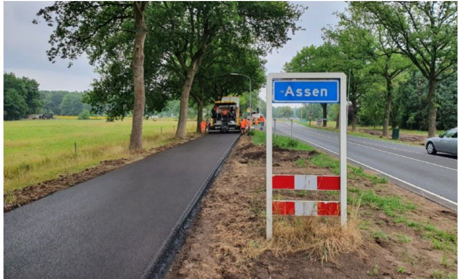
Een van de proefvakken harsfalt in Assen. Foto: Asfalt Kennis Centrum
