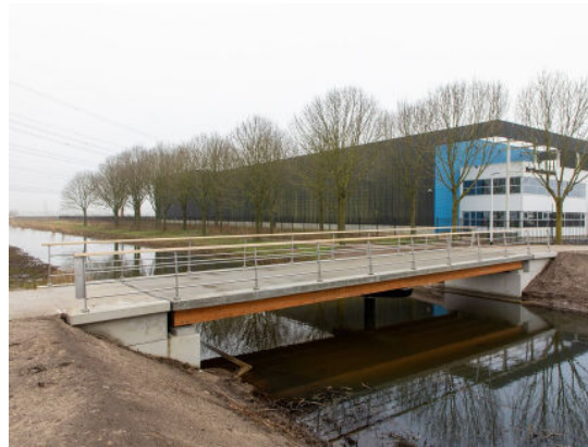
Afbeelding 24: Losmaakbare hout-betonbrug Hessenpoort Zwolle (Bron: gemeente Zwolle, Knipscheer Infrastructuur en ipv Delft z.d.)
