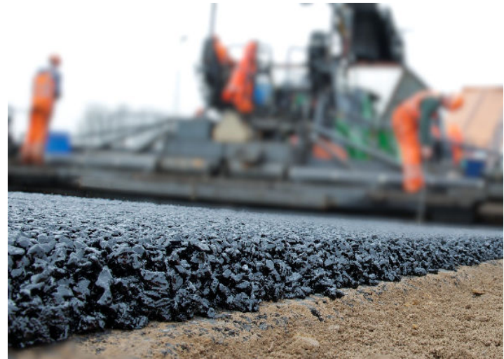
Afbeelding 10: lage temperatuur asfalt (bron: BAM 2023 ).
