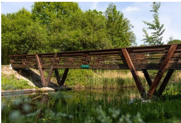
Afbeelding 17: Uitlaatbrug in Almere (Bron: Arc2 Architectuur )
