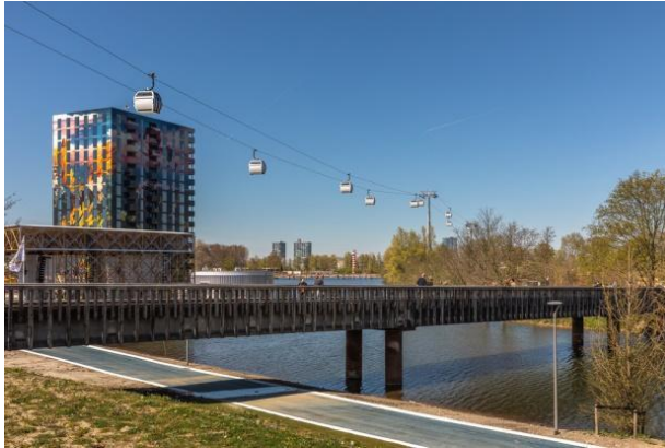
Afbeelding 15: ReUse brug op de Floriade in Almere (bron: Arc2 Architectuur )
